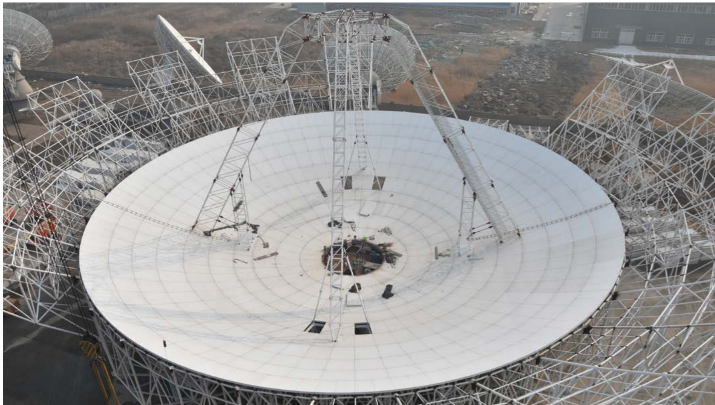
▲ 亚洲最大全可动单体天线反射体整体吊装现场
