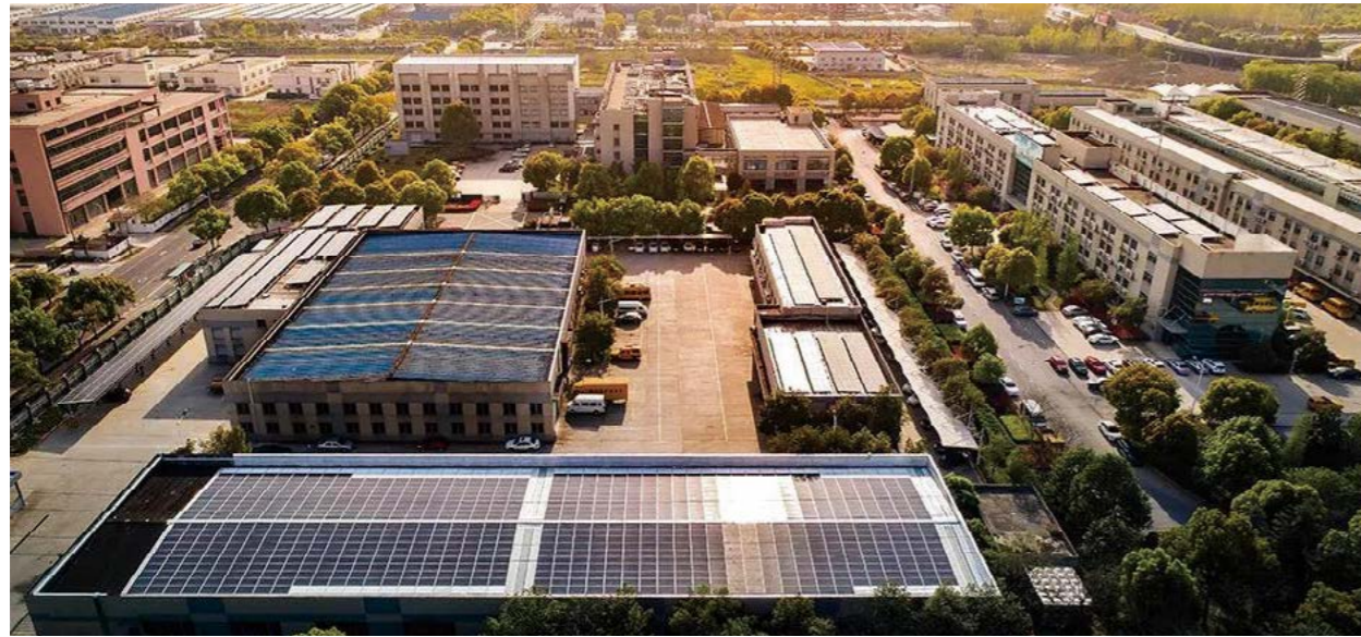
集光伏发电、分布式储能装置和充电桩于一体的综合能源项目在园区应用实施
